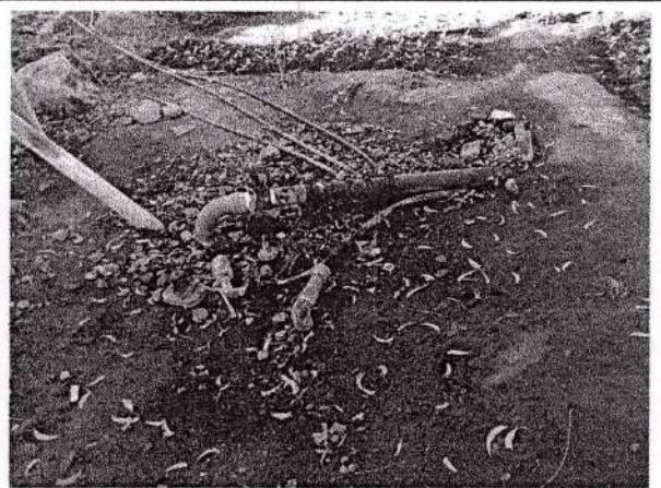
Lokasi rehabilitasi sumur pompa
