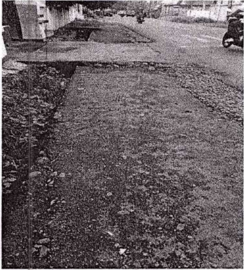
Lokasi pembangunan jaringan perpipaan
