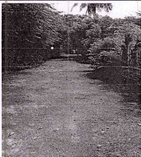
Akses jalan menuju lokasi
