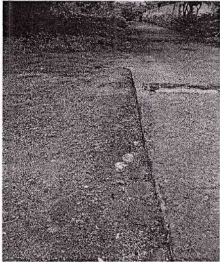
Lokasi pembangunan jaringan perpipaan
